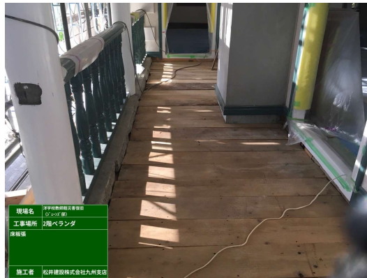
【バルコニー床板張り】
