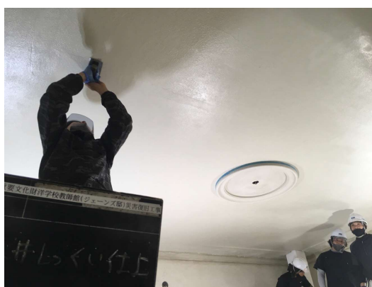
【内部天井仕上】
