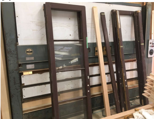
【木製建具調査・修繕】
