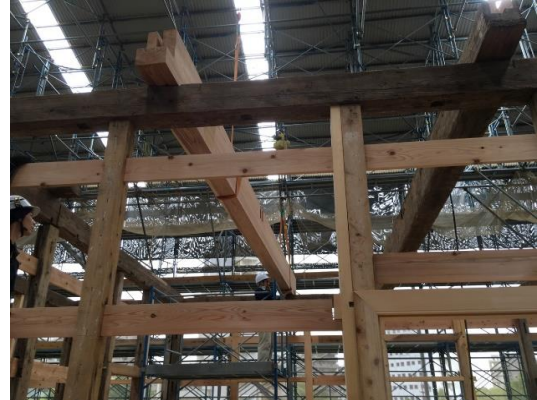
【2階梁材建て方】
