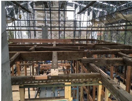
【2階柱建て方完了】
