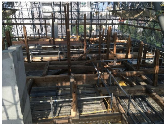
【小屋組み建て方】
