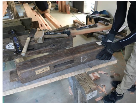
【小屋組材繕い】
