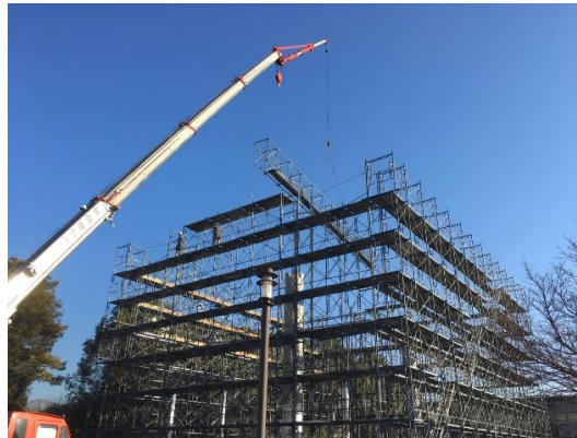
【外部足場架設②】
